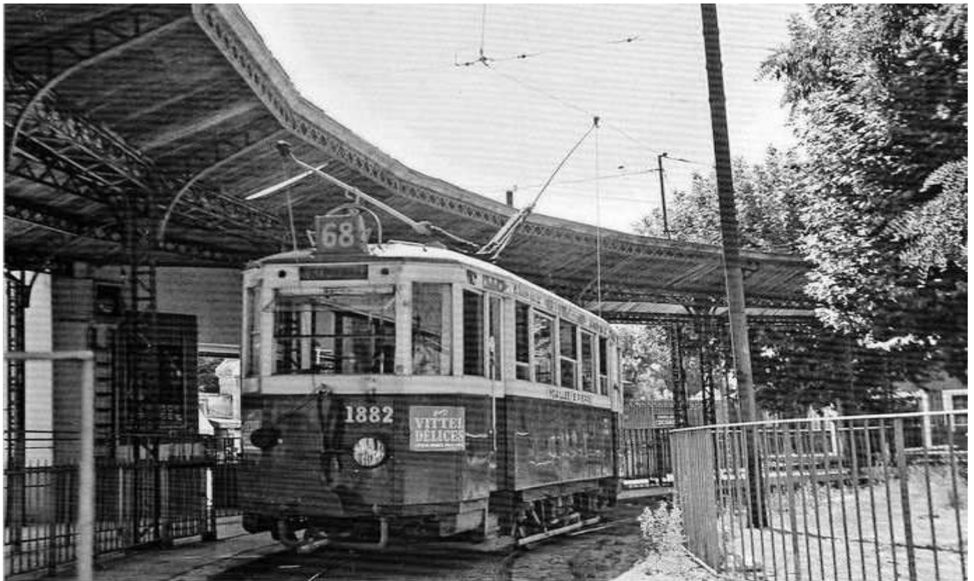
Terminus du Tramway n°68 à Saint-Pierre
