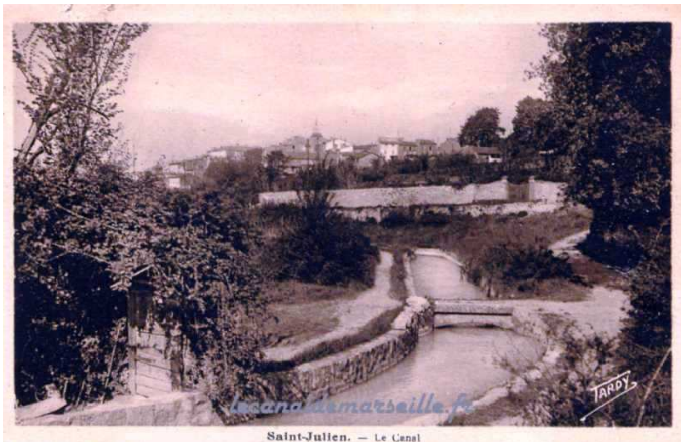
Le Canal de Marseille à Saint-Julien
