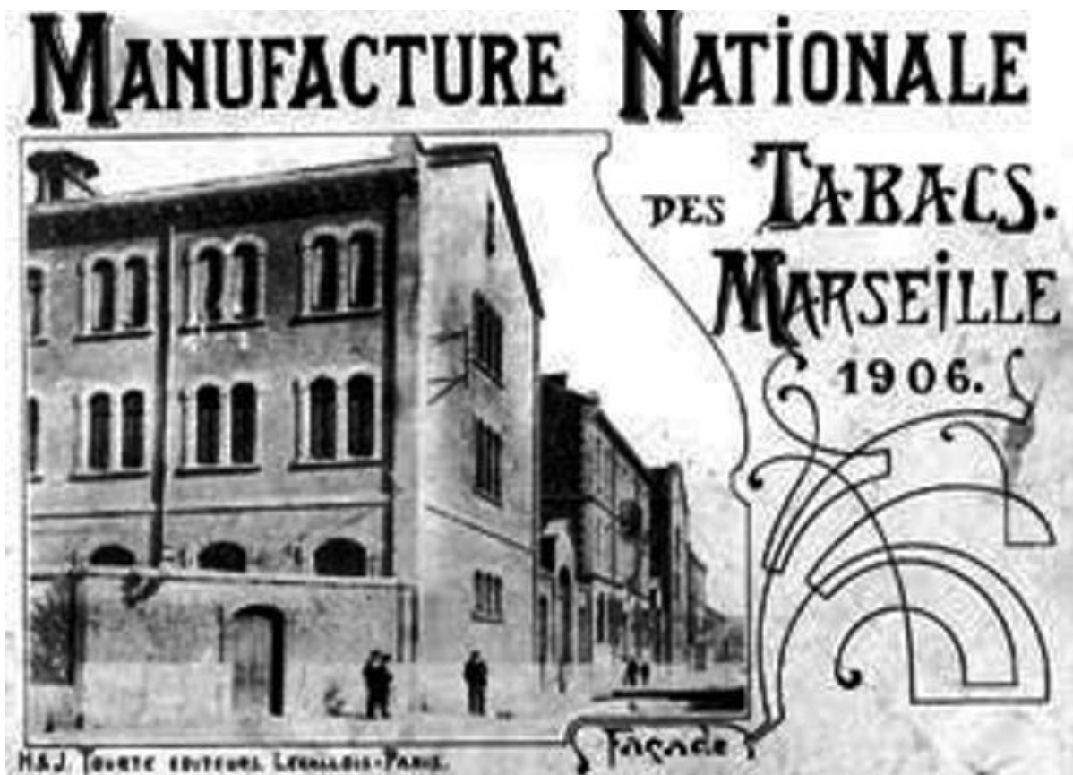
MANUFACTURE DES TABACS RUE GUIBAL
