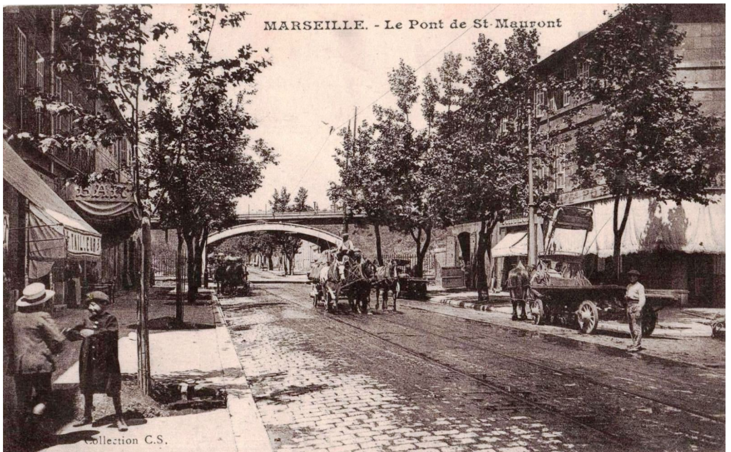
PONT FERROVIAIRE DE SAINT-MAURONT
