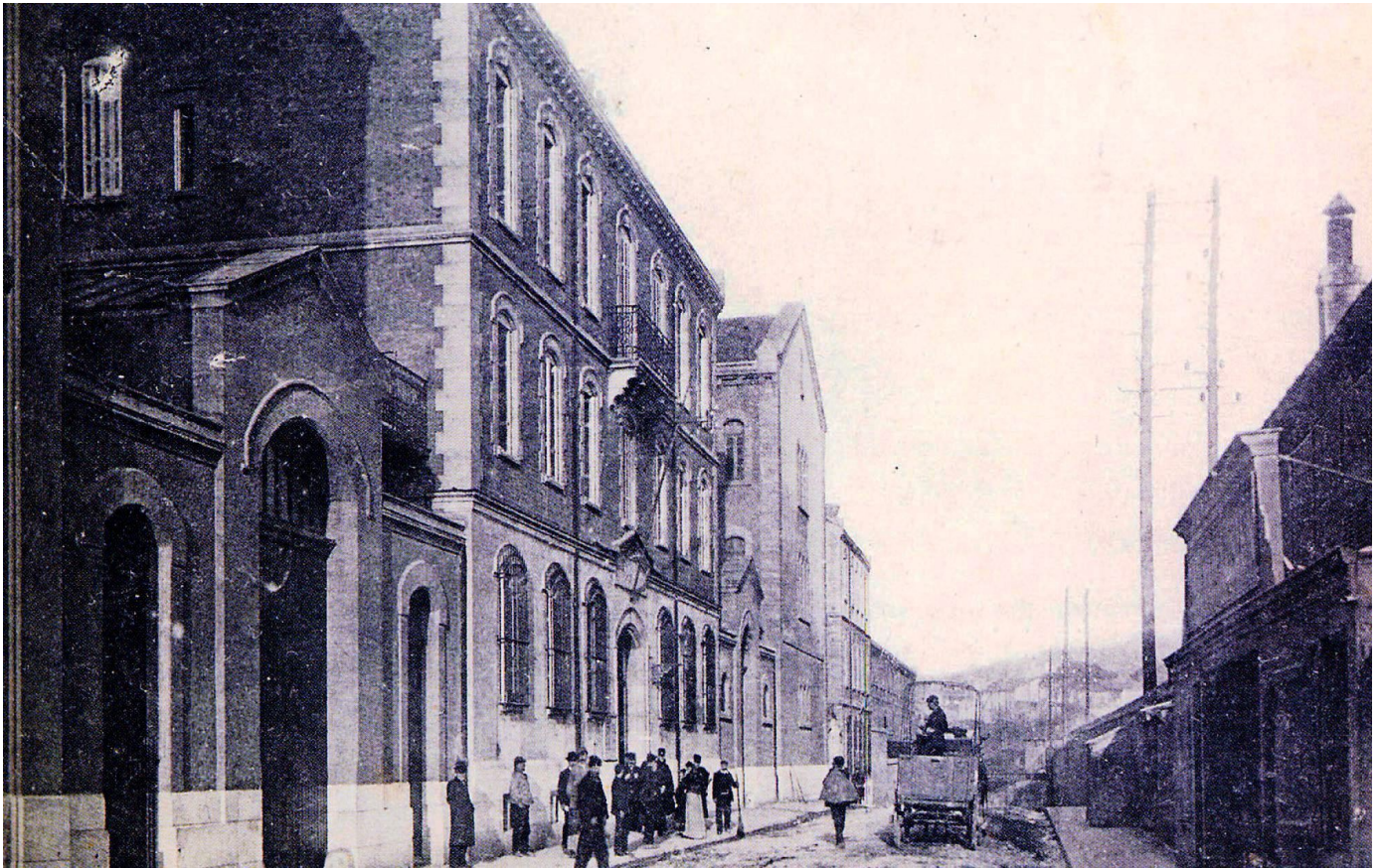
MANUFACTURE DES TABACS RUE GUIBAL
