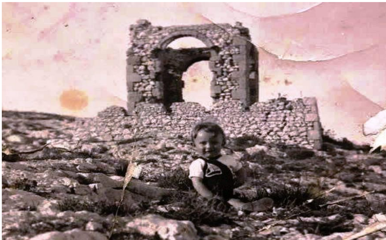
RUINES CHAPELLE DE QUARANTAINE PORT DE POMÈGUES
