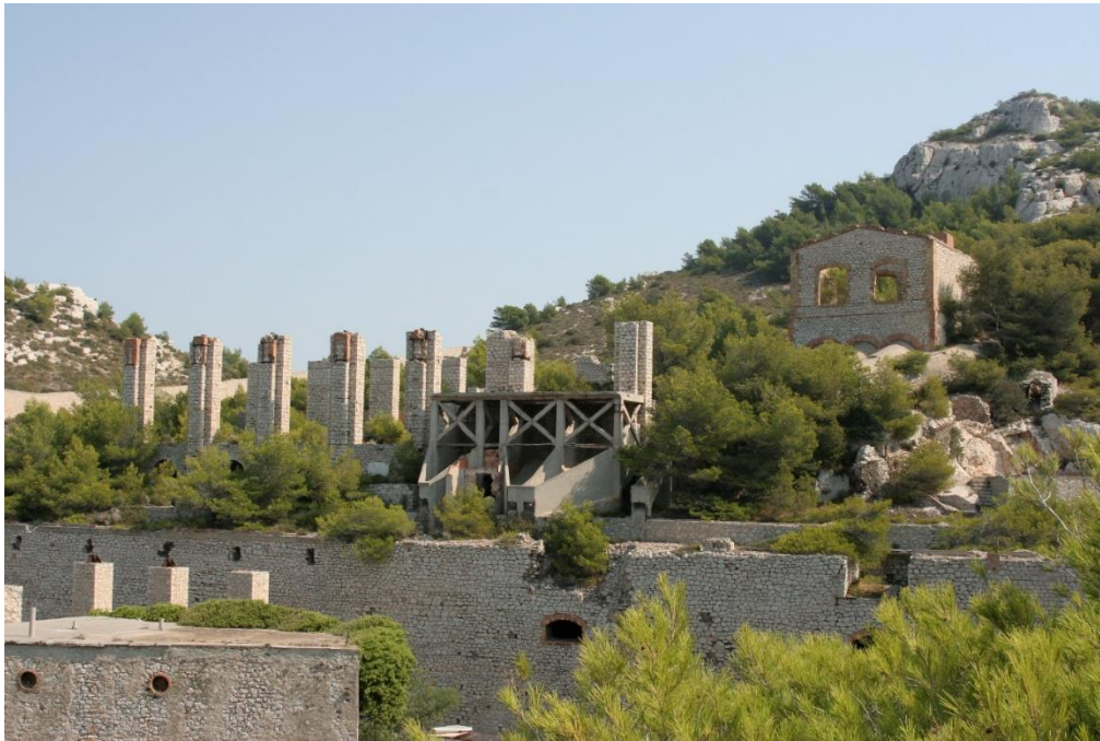
L'Escalette : les vestiges de l'usine
