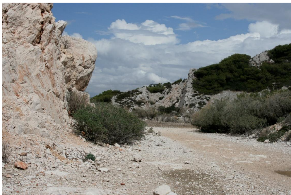
Le projet de chemin de fer : des travaux inachevés...
